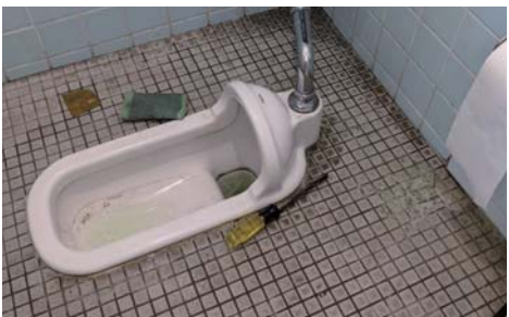
洋式化されていない学校のトイレ
